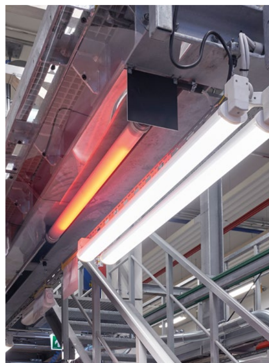
ZUG LED als Signalleuchten in Grün und Rot zeigen an, ob der Bahnstrom für den Abschnitt zu- oder abgeschaltet ist.
