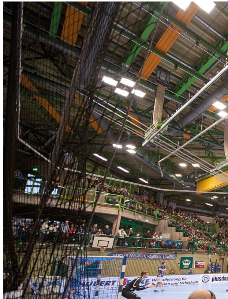
CENTAURUS LED Strahler wurden an eigens entwickelten Traversen an der Trägerkonstruktion des Hallendachs abgehängt.
