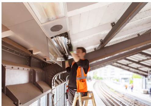
01 Mit passgenauen Umrüstsätzen bringt RENOKIT bestehende NORKA Leuchten auf den neuesten Stand der LED-Technik und erhöht maßgeblich die Effizienz. Abb.: NORKA/Frieder Blickle
